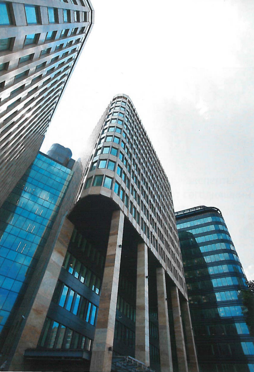
Коммерческий деловой комплекс «Белая площадь»/ABD architects в соавторстве с APA Wojciechowski. Общая площадь 100 000 кв. м, арендуемая — 70 000 кв. м. Реализация: 2009. Подрядчик: компания Enka. Бизнес-центр класса А. Объем инвестиций в проект, реализация которого началась еще в 2004 году, составил 400 млн долл. Средний срок аренды площадей в БЦ составляет 11 лет. Среди арендаторов крупнейшие международные компании PricewaterhouseCoopers, Deloitte & Touche, McKinsey и Microsoft.
