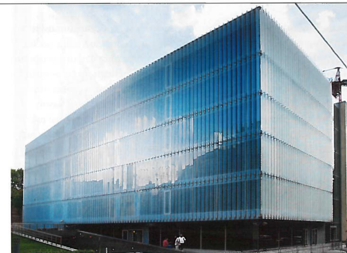
Офисное здание в Бутиковском пер./Арх. мастерская «Проект Меганом». Архитекторы: Юрий Григорян, Александра Павлова, Илья Кулешов, Юлия Бычкова, Наталия Татунашвили. Заказчик: RGI International. Реализация: 2007–2008. Ю. Григорян: «Так уж сложилось, что все дома в этом переулке насыщены архитектурным содержанием. Может быть, даже чересчур. Поэтому это здание мы решили сделать нейтральным, между собой его называли — «Эфир». Это не вполне архитектура, скорее арт-объект. В отличие от соседей, норовящих заявить о себе, это что-то такое исчезающее».
